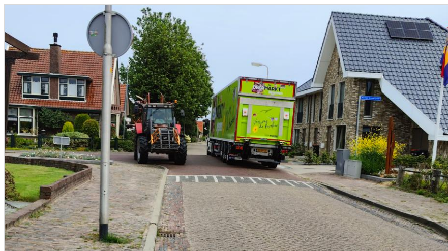
Afbeelding 9.20: Passerende vrachtauto en tractor op een rijbaanbreedte van 5,50 m.
