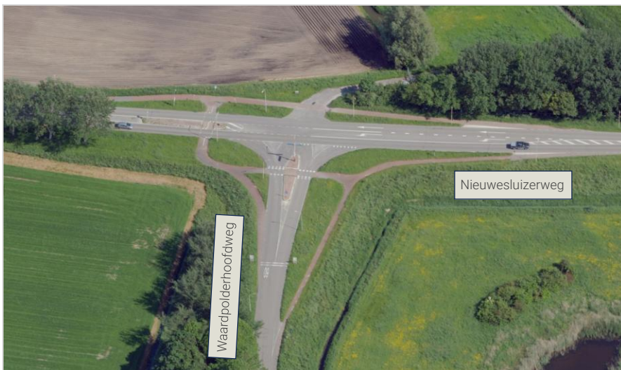
Afbeelding 9.6: Luchtfoto bestaand kp. Nieuwesluiserweg - Waardpolderhoofdweg.
