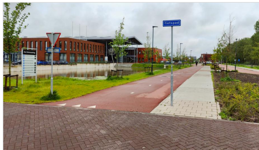
Afbeelding 8.5: Ontbrekende boogstralen aansluiting fietspad De Verwachting op Robijn.
