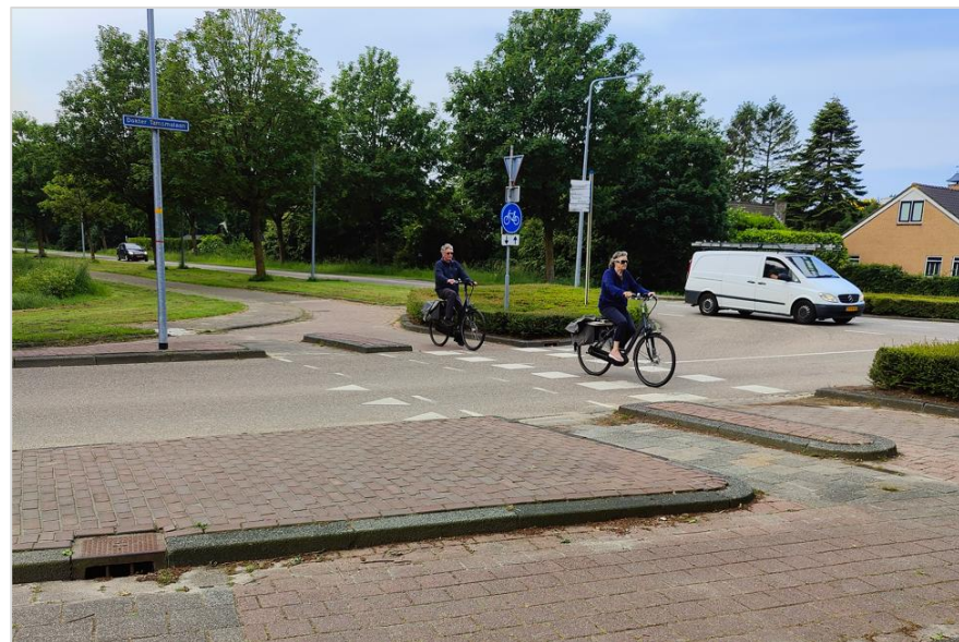
Afbeelding 2.5: Vormgeving fietsoversteek met beperkte breedte.
