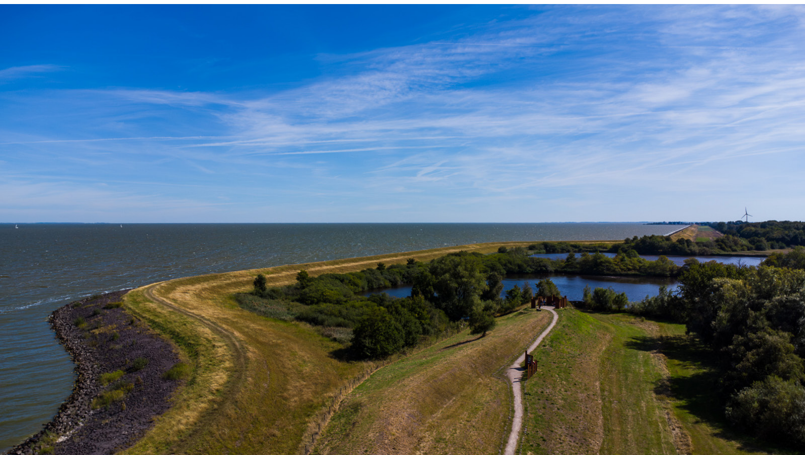
Zicht op monument Gat in de dijk
