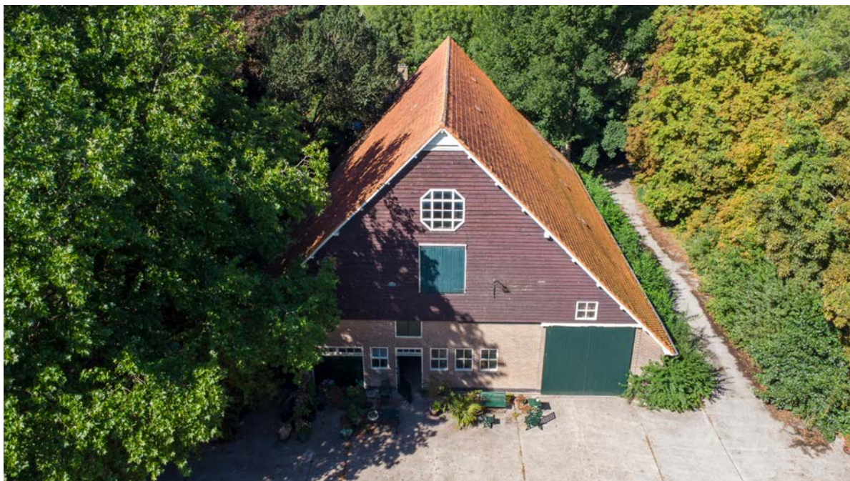
Wieringermeerboerderij type Q7H aan de Schervenweg
