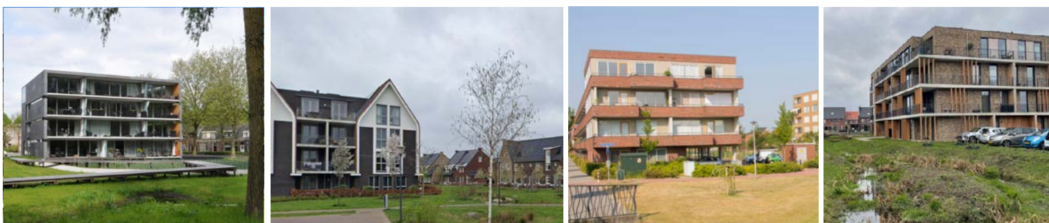
Appartementen aan het Slenkenpark
