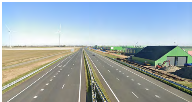
Zicht vanaf het viaduct
