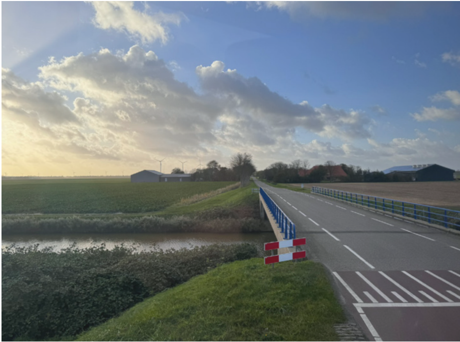
Zicht op het akkerbouwlandschap ter hoogte van een van de bruggen over de Robbevaart: één van de hoofdvaarten in de Wieringermeer
